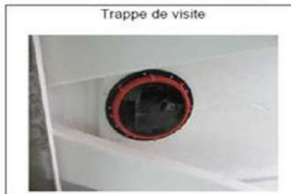
Trappe de visite
